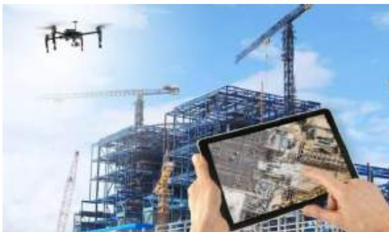
Рисунок 3 – Производство аэрофотосъемки строительного объекта.
