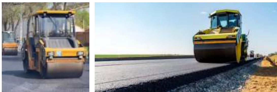
Рисунок 5 – Работа катков при устройстве асфальтобетонного покрытия.
