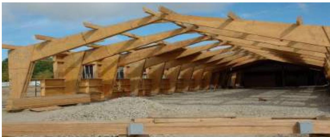
1-сурет – Ағаш қаңқалы екі жартыарқадан жасалған кеңістікті ғимарат.
