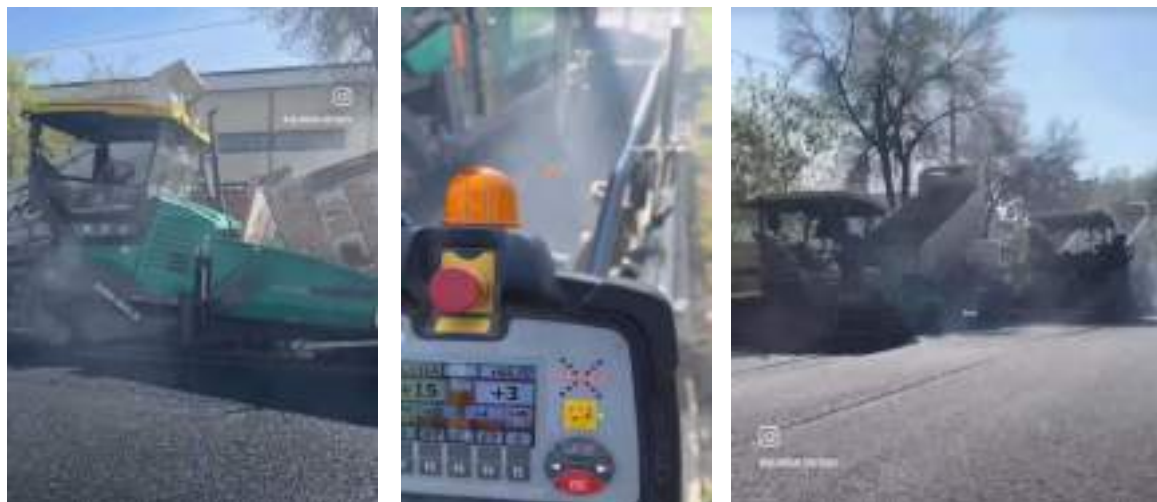
Рисунок 4 – Работа асфальтоукладчика при устройстве асфальтобетонного покрытия.
