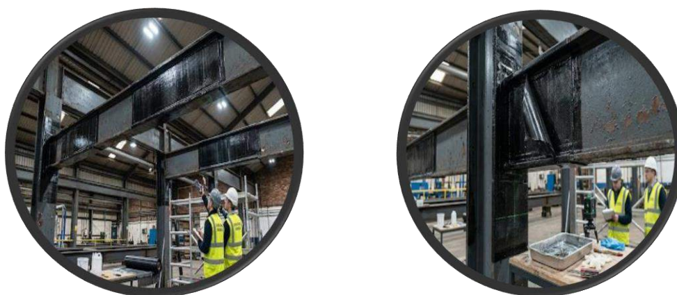
Рисунок 5 – Усиление стальной балки композитным материалом.
