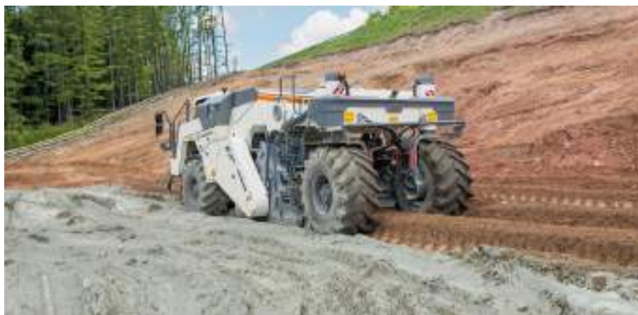
Рисунок 2 – Технология цементной стабилизации грунта.
