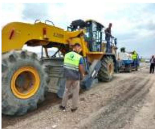
Рисунок 2 – Стабилизация грунта методом ресайклированием.
