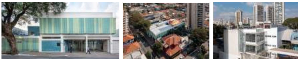
Рисунок 3 – Трансформация здания автосалона в школу Camipo (Бразилия)
