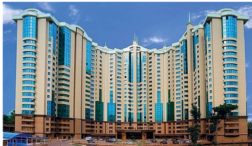
Рисунок 2 – 23-этажное высотное здание ЖК «Столичный центр». Алматы, РК
