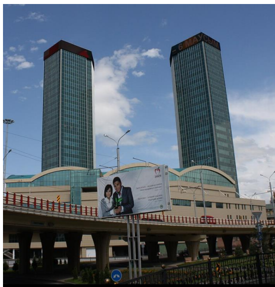
Рисунок 3 – 25-этажное высотное здание Многофункциональный деловой комплекс «Almaty Towers». Алматы, РК
