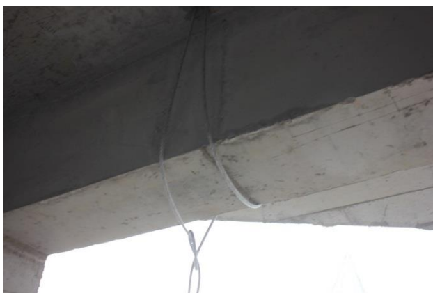
Рисунок 27 – Крепление троса к конструкциям здания
