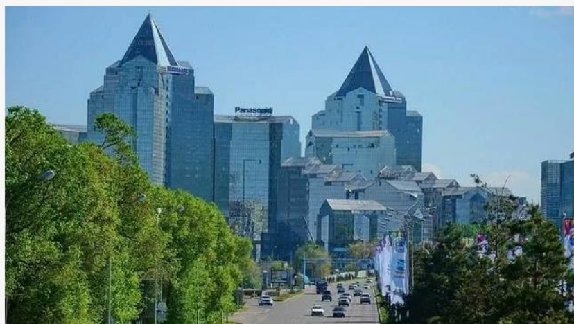
Рисунок 5 – 28-этажное высотное здание ЖК «Нурлы-Тау». Алматы, РК
