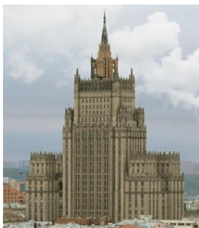
Рисунок 7 – Здание МИД РФ на Смоленской Сенной площади, высота каркаса 125 м. г. Москва, РФ
