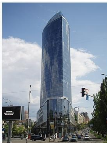
Рисунок 9 – 33-этажный офисный бизнес-центр ТОК «Парус». г. Киев, Украина
