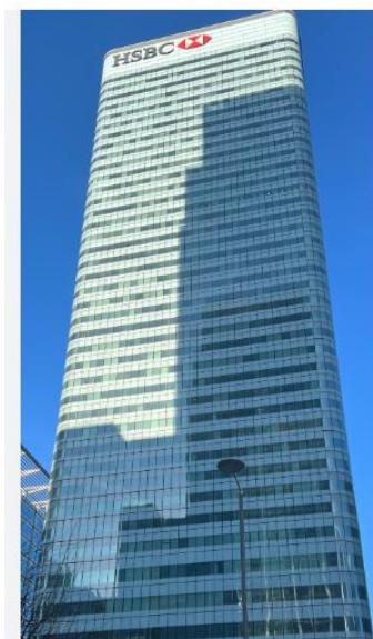
Рисунок 10 – Здание банка «HSBC» высотой 178,8 м. г. Гонконг, КНР
