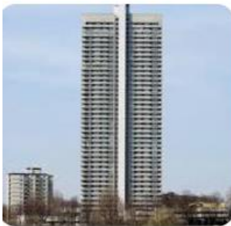
Рисунок 8 – 42-этажный высотный жилой дом «Colonia-Haus». г. Кёльн, Германия
