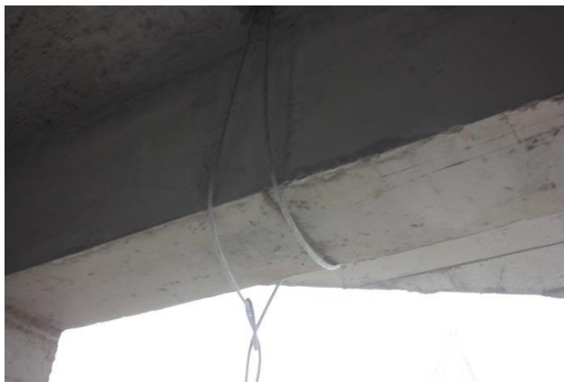
Рисунок 27 – Крепление троса к конструкциям здания
