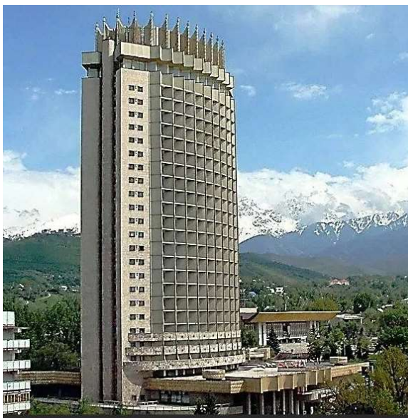
Рисунок 1 – 25-этажное здание гостиницы «Казахстан» в г. Алматы
