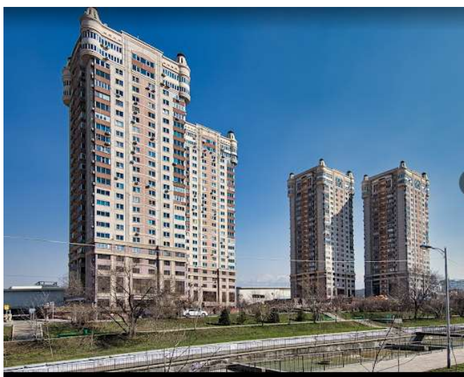
Рисунок 6 – 25-этажное высотное здание ЖК «Mega Tower Almaty» в г. Алматы
