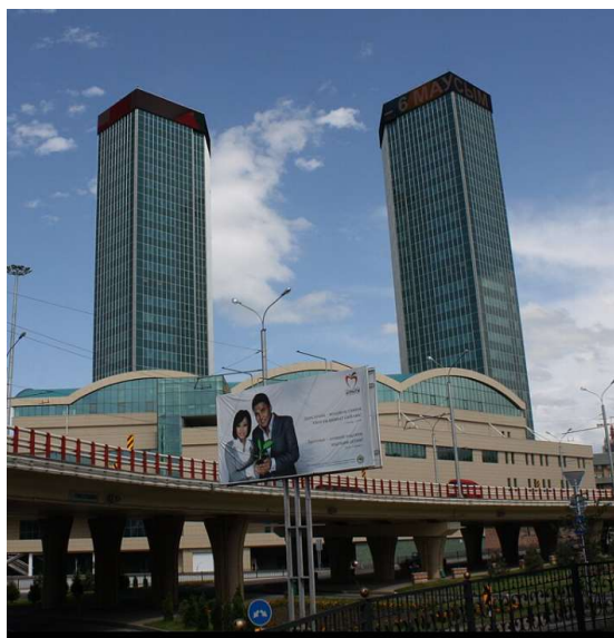
Рисунок 3 – 25-этажное высотное здание Многофункциональный деловой комплекс «Almaty Towers» в г. Алматы
