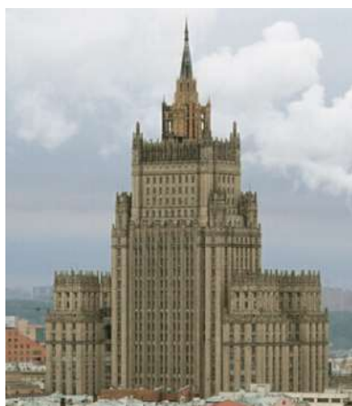
Рисунок 7 – Здание МИД РФ на Смоленской Сенной площади, высота каркаса 125 м
