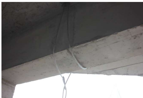
Рисунок 26 – Крепление троса к конструкциям здания
