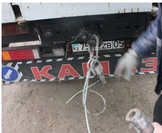
Рисунок 27 – Вставка соединения троса с силовой установкой (автомашина)
