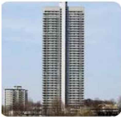
Рисунок 7 – 42-этажный высотный жилой дом «Colonia-Haus» в г. Кельн (Германия)
