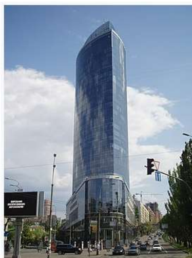
Рисунок 8 – 33-этажный офисный бизнес-центр ТОК «Парус» в г. Киев (Украина)
