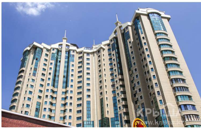
Рисунок 2 – 23-этажное высотное здание ЖК «Столичный центр» г. Алматы
