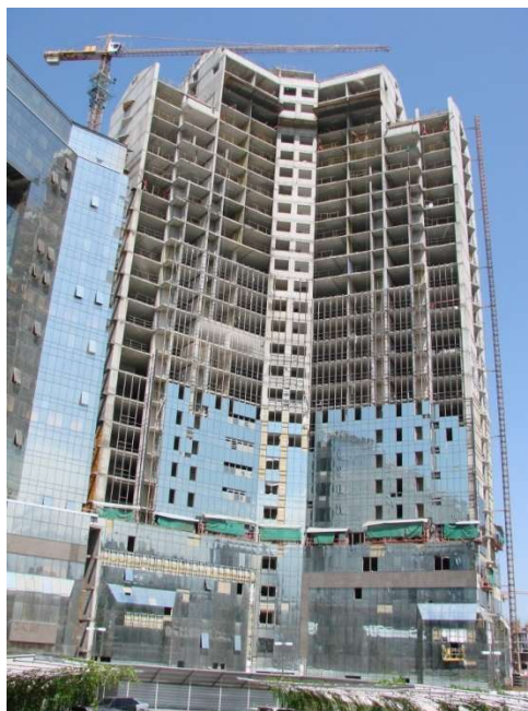
Рисунок 14 – Общий вид экспериментального высотного здания
