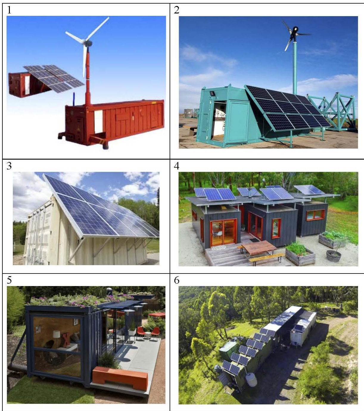
1, 2, 3 – контейнерные дифференцированные и интегрированные ветрогенераторы и гелиогенераторы [372]; 4, 6 – солнечные батареи на крыше эксплуатируемых для жилья контейнеров [373]; 5 – устройство цветников на крыше эксплуатируемых для жилья контейнеров [374]
