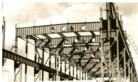
Рисунок 8 – Покрытие производственного здания завода крупнопанельного домостроения в Алматинской области [23 с.80].
